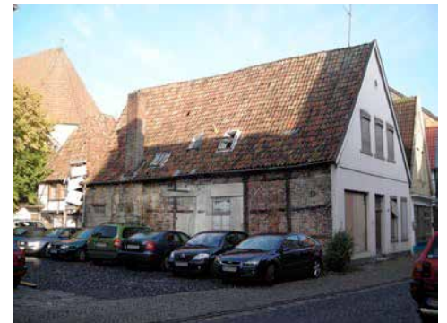
Haus Kirchstraße 14, Steinfurt
